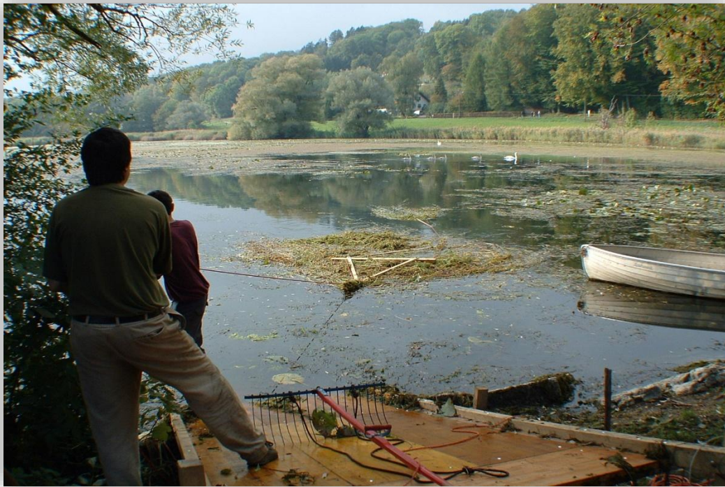
Abb. 2: Rampenkonstruktion zur manuellen Reduktion des Wasserpflanzenbestandes
